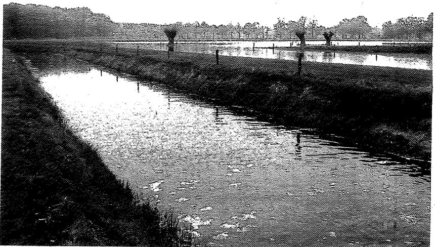
Zicht op kanaal de Grootte Vloedgraven (op beide foto's uiterst links). Rechts van het kanaal het droge land (foto boven) van boer Kerkmeijer dat als bergingsgebied dient (foto onder) als het peil in de Vloedgraven te hoog wordt. FOTO'S ALTERRA
